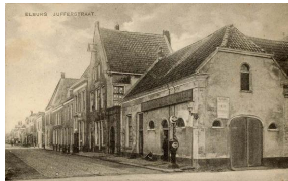
Een foto uit circa 1920 van de synagoge aan de Jufferstraat in Elburg. De synagoge was bereikbaar via de poort [2].
