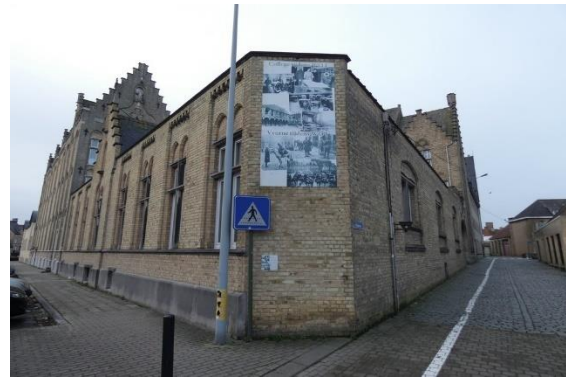
Het Bisschoppelijk college in Veurne dat in de Eerste Wereldoorlog dienstdoet als Brits veldhospitaal. Als herinnering aan deze periode is een plaquette aangebracht aan de gevel [7].
