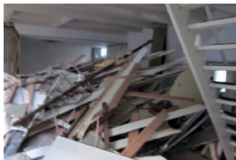
Het strippen van Zuiderwalstraat 11 verloopt in hoog tempo.
