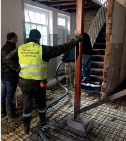
Meerdere lagen betonijzer!
