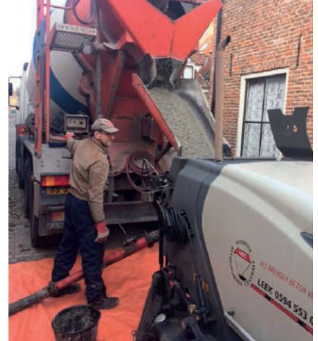
Via de betonmixer wordt de betonmortel in een pomp overgeheveld...
