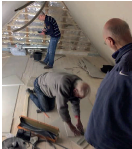
Reijer Spaan, Wim Schenk en Jetze Kuipers zijn druk in de weer met het isoleren van de kap van ZWS 11.
