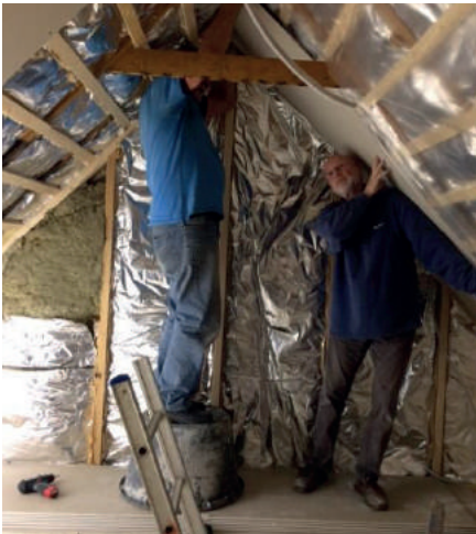
Reijer Spaan, Wim Schenk en Jetze Kuipers zijn druk in de weer met het isoleren van de kap van ZWS 11.
