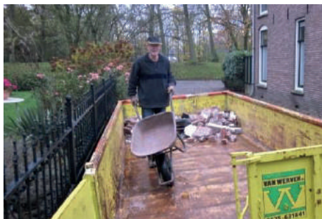
Er zijn heel veel containers gevuld met sloopmaterialen...
